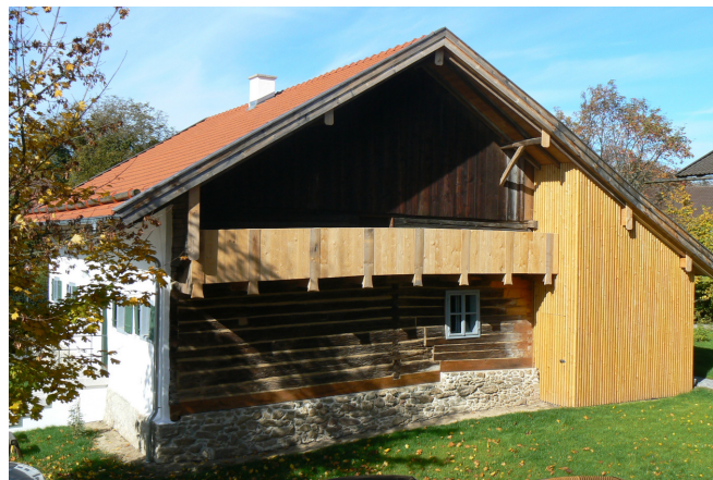
Ostseite der sanierten Hien-Sölde, Balken seit 1436 unverputzt
