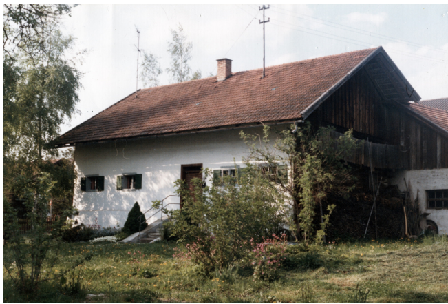
Süd-Ost Ansicht der Historischen Hien-Sölde, um 1980
